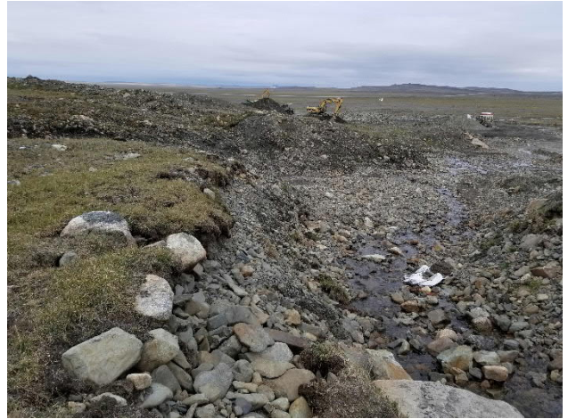
Photo 25 : vue la rive gauche du cours d'eau CE1
