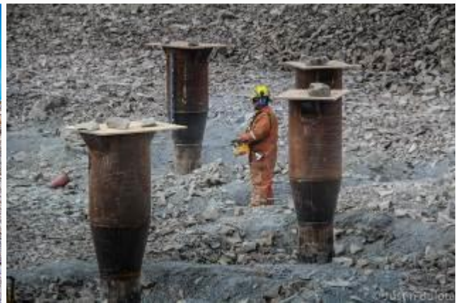
Exemple de fondation sur pieux
