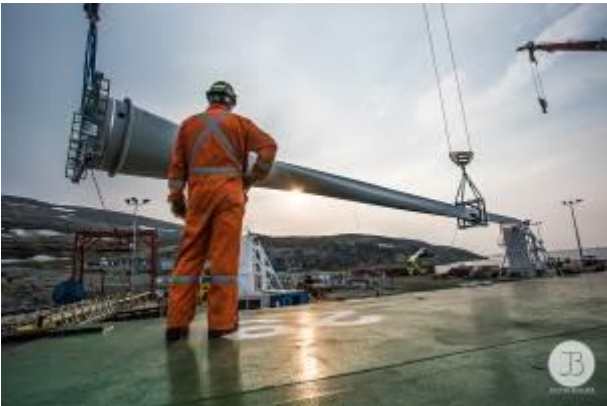
Déchargement d'une pale d'éolienne de 40 mètres à partir d'un navire au Nunavik
