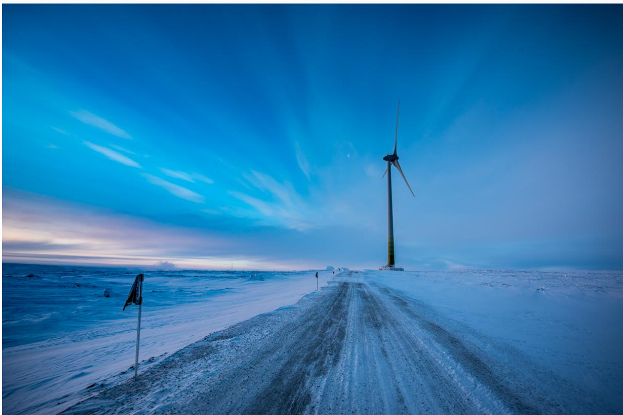
Exemple de route d'accès d'une largeur de 6 mètres menant à l'éolienne à la mine Raglan au Nunavik
