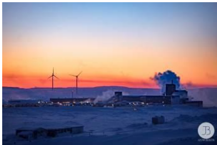
Les deux éoliennes en opération à la mine Raglan
